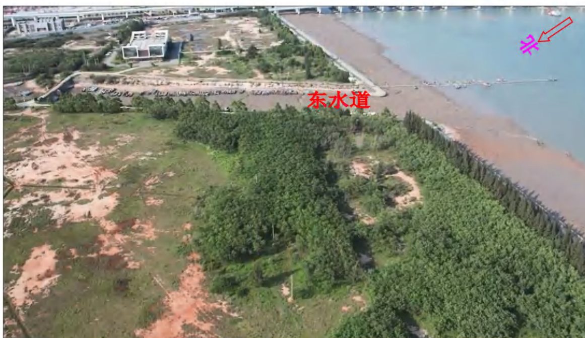
图 3.2-7 项目位于东水道两侧用地（吹填区）现状航拍图
