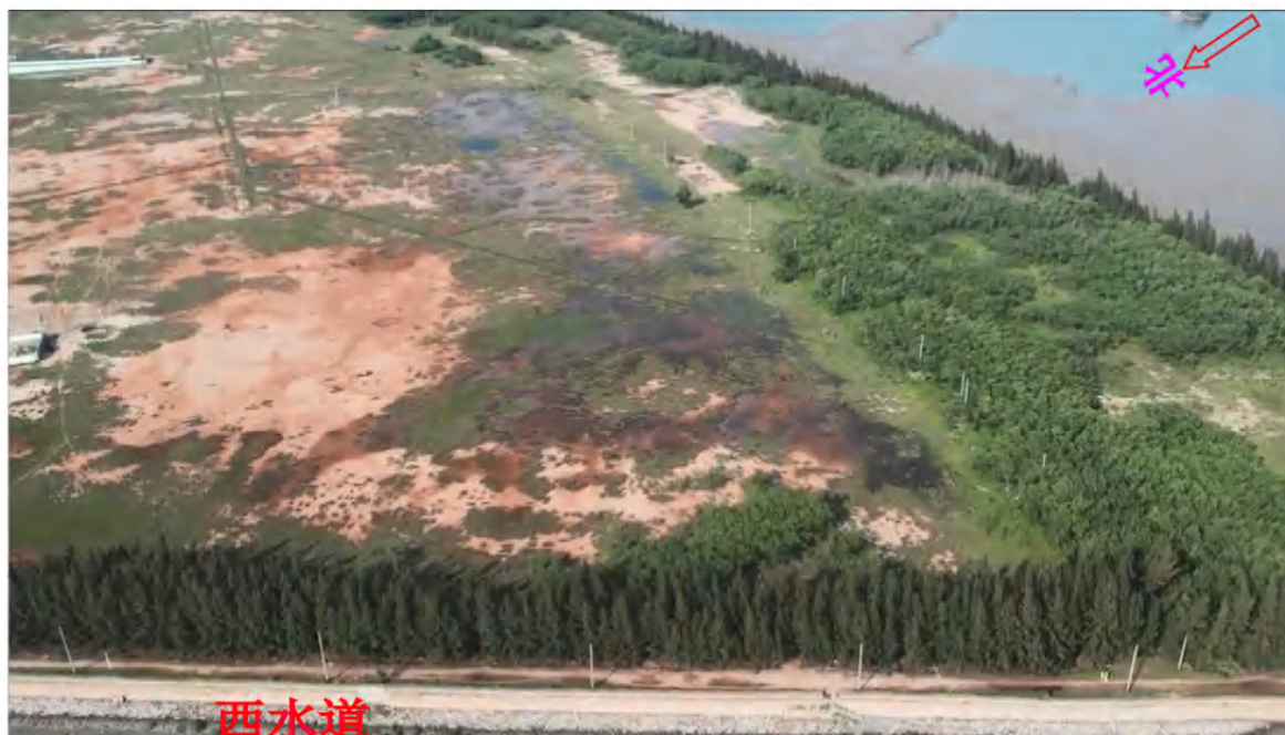
图 3.2-6 项目位于西水道东侧用地（吹填区）现状航拍图
